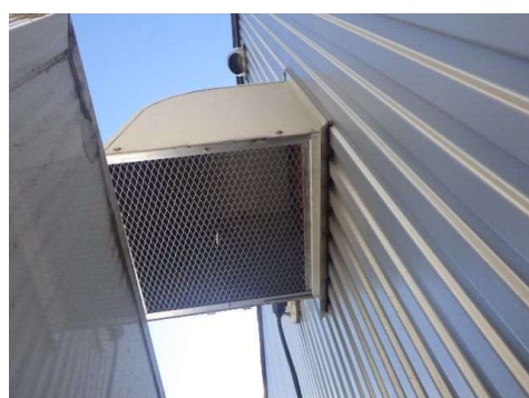
本社事務所台所換気扇ダクトのフィルター掃除
